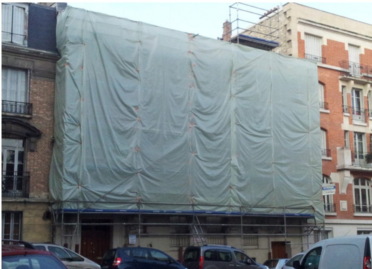
Protección con lona alquitranada antes de retirar el revestimiento plástico por procedimiento químico.
