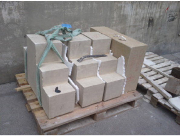
Piedras que se deberán reemplazar. La colocación de nuevas piedras necesita de medios importantes para elevarlas
