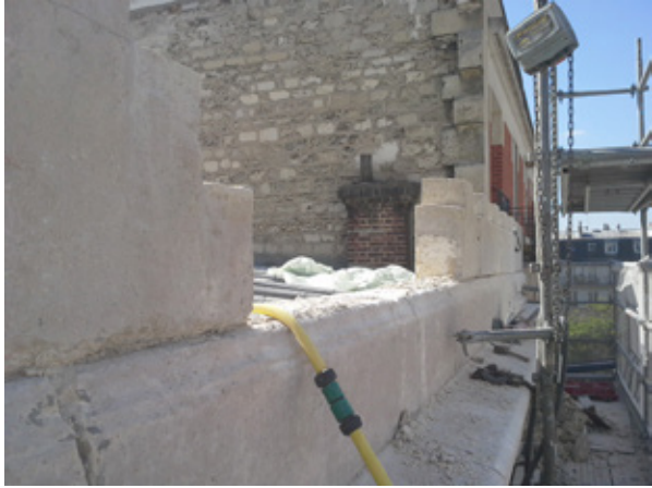
Piedras que se deberán reemplazar. La colocación de nuevas piedras necesita de medios importantes para elevarlas
